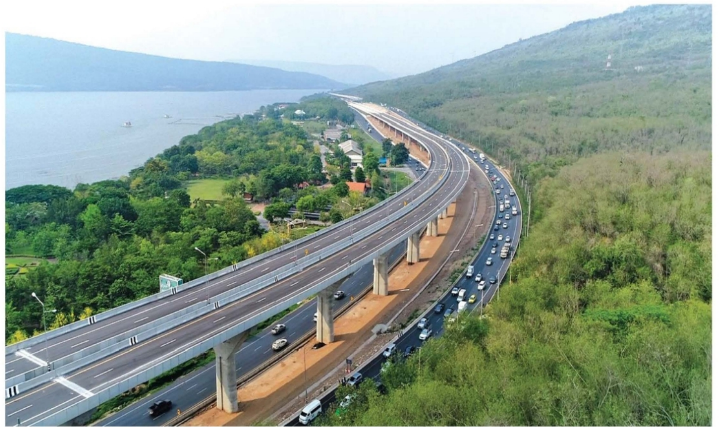
ปิดปลายปี'65 - ภาพความก้าวหน้ามอเตอร์เวย์บางปะอิน-โคราช ปัจจุบันงานก่อสร้างคืบหน้าไปกว่า 80% กรมทางหลวงจะทดลองเปิดให้วิ่งบางช่วงปลายปี 2565 ก่อนจะเปิดบริการเต็มรูปแบบในปี 2566 เพราะต้องรองานระบบเก็บค่าผ่านทางแล้วเสร็จก่อน
