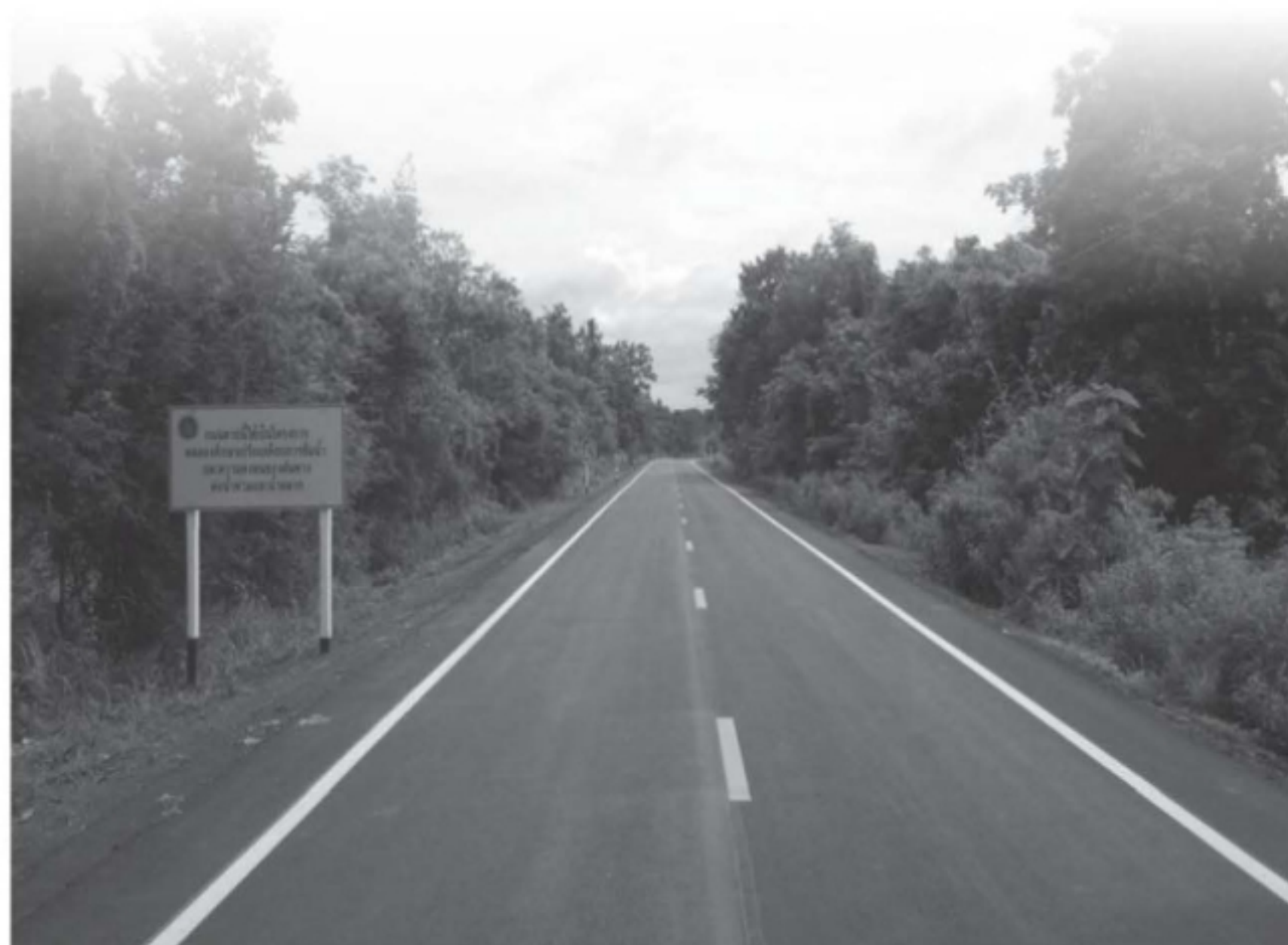
ทช. นำร่องใช้ยางพาราเป็นส่วนผสมก่อสร้างถนน สาย นว.4026 จ.นครพนม เพื่อทดสอบความคงทนของคืนทางต่อสภาวะอุทกภัย
