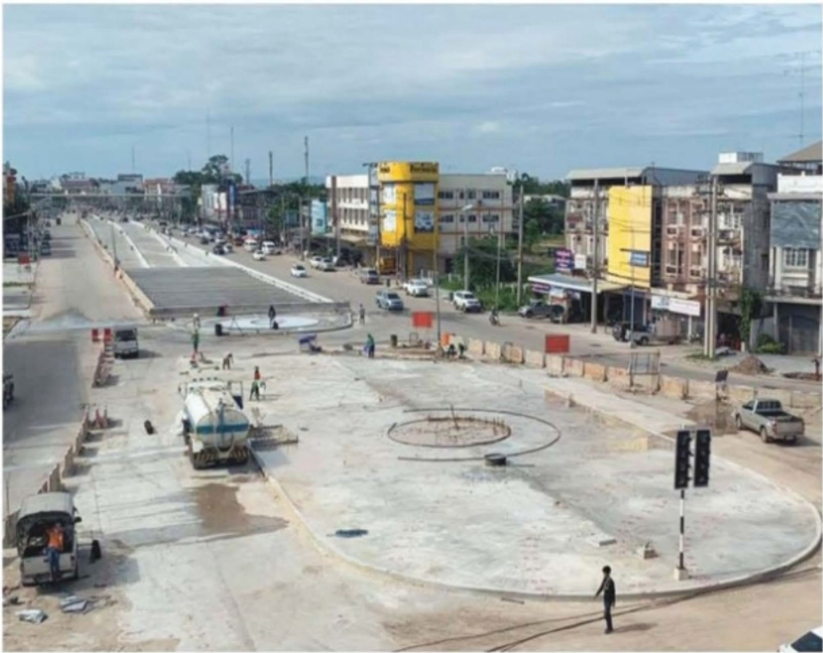
เปิดอุโมงค์ - จังหวัดอุดรธานี ร่วมกับกรมทางหลวง และเทศบาลนครอุดรธานี จัดกิจกรรม “ออนซอน อุโมงค์ลอดทาง” โครงการทางแยกต่างระดับ และอุโมงค์ทางลอดอุดรธานี-ด้านเหนือ ในวันที่ 23 พฤศจิกายน 2562 ก่อนเปิดให้บริการเป็นทางการในวันที่ 24 พฤศจิกายน 2562 ทั้งนี้ภายในงานจะจัดกิจกรรมเดิน-วิ่ง-ปั่น ชมอุโมงค์แห่งแรกของอุดรฯ และกินลมชมวิวบนสะพานลอยแห่งใหม่
