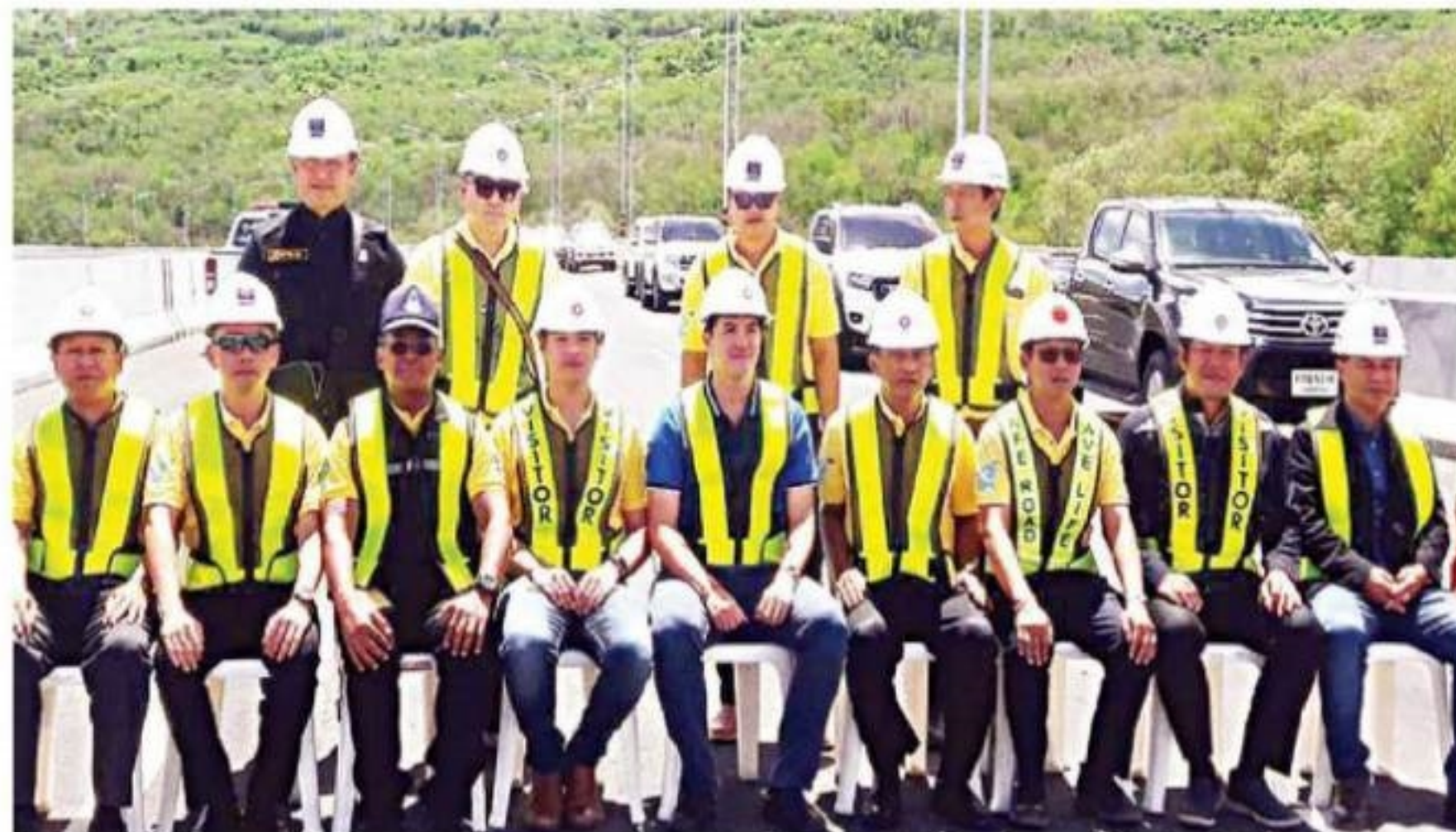
มอเตอร์เวย์...นายอชิรัฐ รัตนเศรษฐ รถมช.คมนาคม ลงพื้นที่ตรวจติดตามโครงการก่อสร้างทางหลวงพิเศษระหว่างเมืองหรือมอเตอร์เวย์ บางปะอิน-นครราชสีมา (M6) ระยะทางประมาณ 200 กม. จ.นครราชสีมา โดยเร่งรัดการก่อสร้างและการเบิกจ่ายงบประมาณเพื่อให้สามารถเปิดให้บริการได้ภายในปี 64
