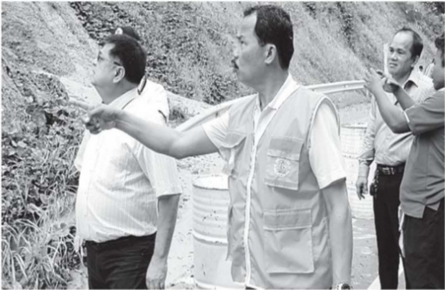
ตรวจพื้นที่ สมัย โชติกุล ผู้ตรวจราชการกระทรวงคมนาคม ลงพื้นที่ตรวจดูความเสียหายดินสไลด์จากภูเขาลงมาปิดทับเส้นทางถนนสายบ้านที่วัง-จุฬาภรณ์-บ้านสวนเลา หมู่ 10 ต.ที่วัง อ.ทุ่งสง จ.นครศรีธรรมราช หลังเกิดพายุถล่มและฝนตกหนัก.
