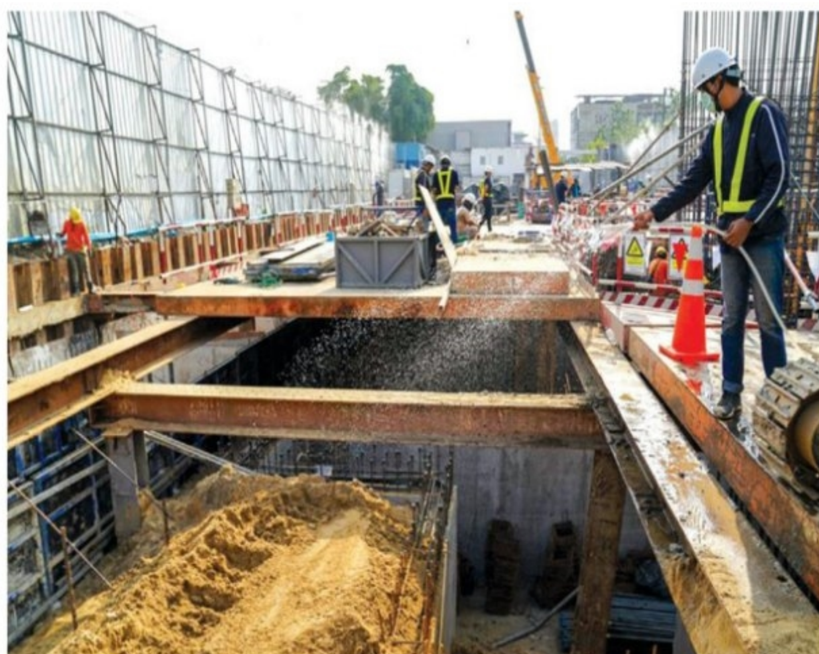
▲ ภาพฉีดน้ำพรมลงบนทรายในไซต์ก่อสร้างเพื่อลดการเกิดละอองฝุ่น
