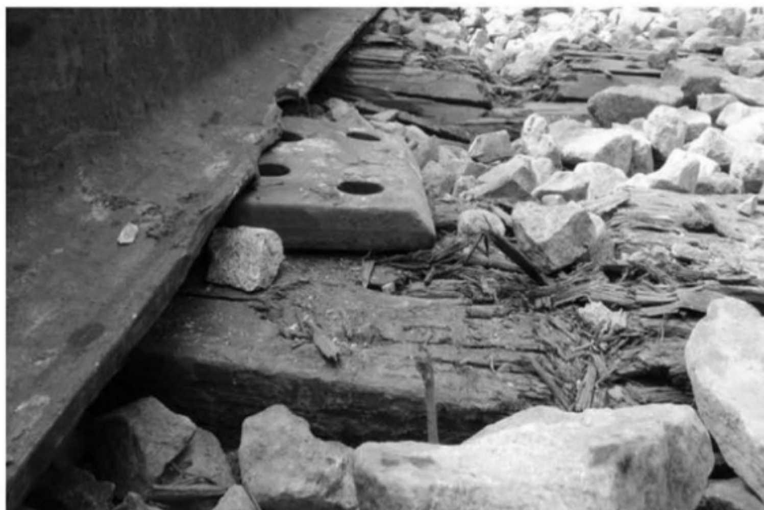
เหล็กรองรางถูกถอดหมุดยึด
