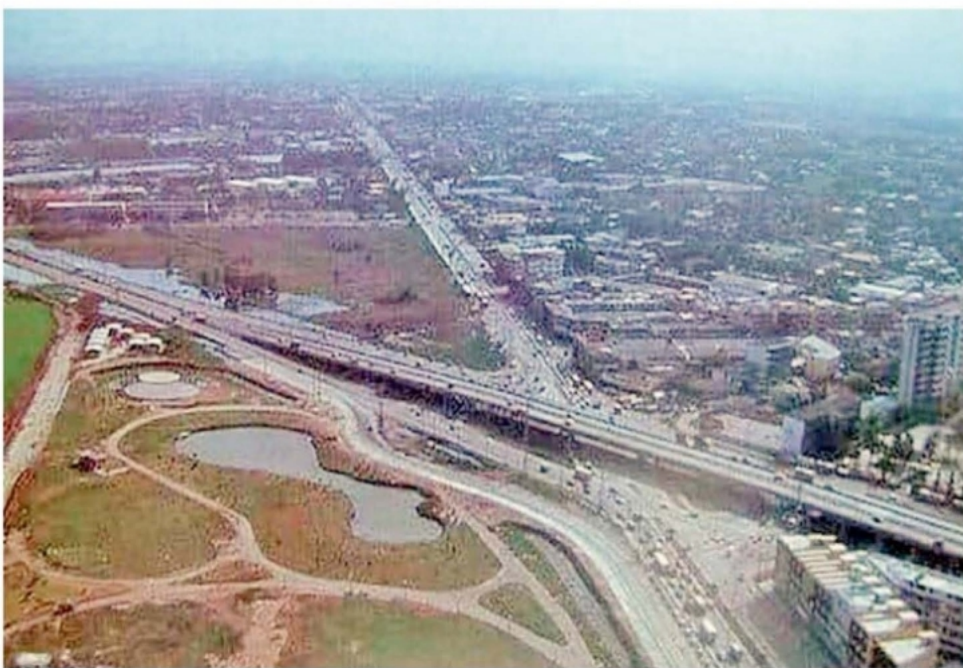
ภาพถ่ายมุมสูง กำลังสร้างสวนจตุจักร
